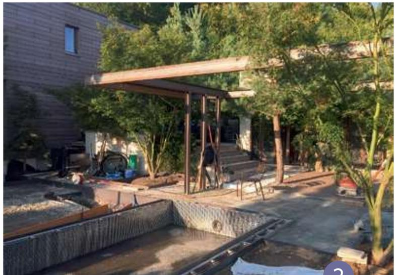
**2 KONSTRUKTION PERGOLENDACH** Das Dach ist als Vollholzdecke konstruiert, die in einen Metallrahmen eingepasst wurde.
