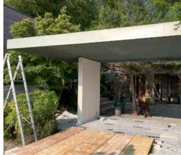
**4 BAUWERKSKONSTRUKTION** Eine Stahlkonstruktion (H-Profile) trägt das Dach der Pergola. Die einzelnen Stützen sind mit Zementfaserplatten ausgekleidet und bilden so vollflächige Wände. Im Hohlraum dazwischen ließen sich die Leerrohre für Steckdosen sowie der Wasserhahn und die Armatur für die Dusche
